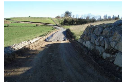
Illustration 23 : Mise en place du gravier
