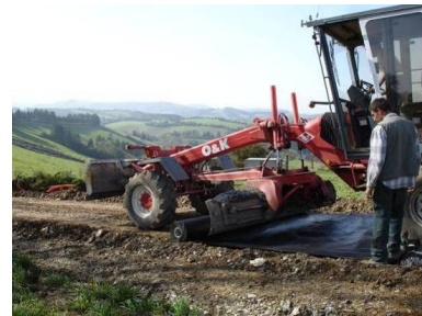
Illustration 22 : Pose du géotextile
