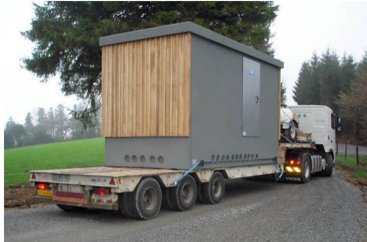
Illustration 13 : Arrivée d'un poste de livraison sur un site éolien
